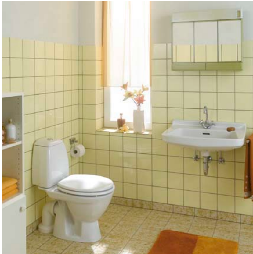
Baño antes de la reforma
